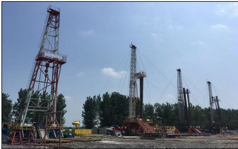
图 4 1010-1 工作面“四含”注浆改造试验工程
